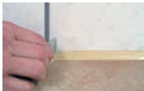
Fugenboy mit Glättmittel benetzen und abziehen
