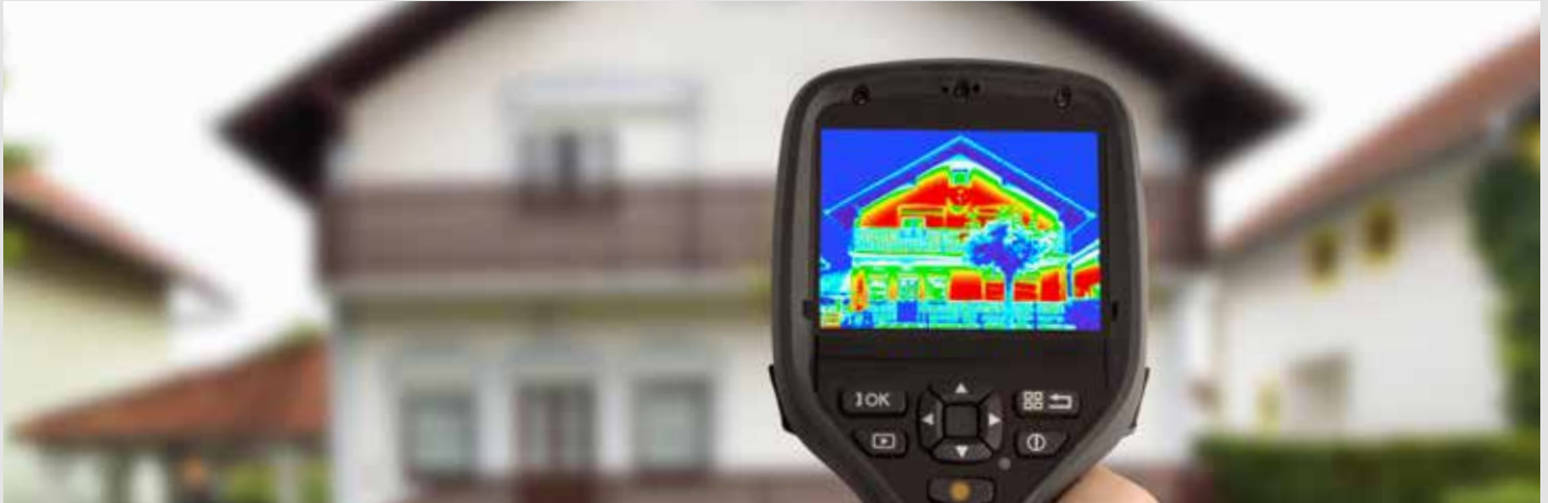
Die roten Stellen dieser Thermografie machen sichtbar, wo am Haus die Schwierigkeiten liegen und am meisten Wärme verloren geht.
